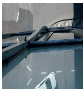
Rys. 2. Skutek braku właściwego rozmieszczenia dylatacji metalowo-szklanej struktury elewacyjnej
